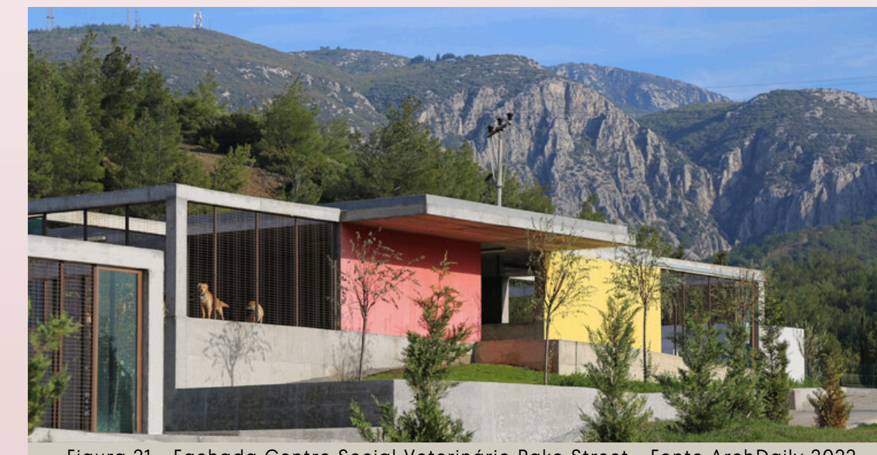
Figura 21 - Fachada Centro Social Veterinário Pako Street - Fonte ArchDaily 2022.
