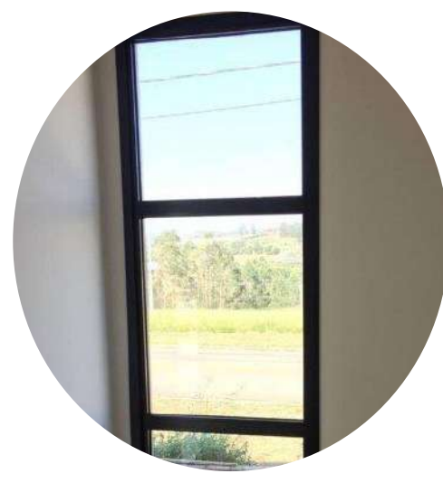
ESQUADRIAS DE ALUMÍNIO PRETO
