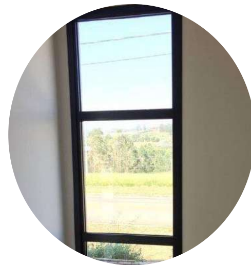
ESQUADRIAS DE ALUMÍNIO PRETO
