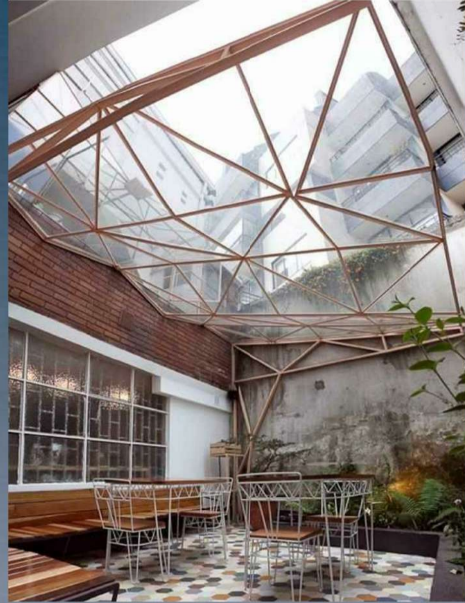
Cobertura em vidro com proteção solar
