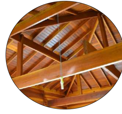
Estrutura do telhado aparente
