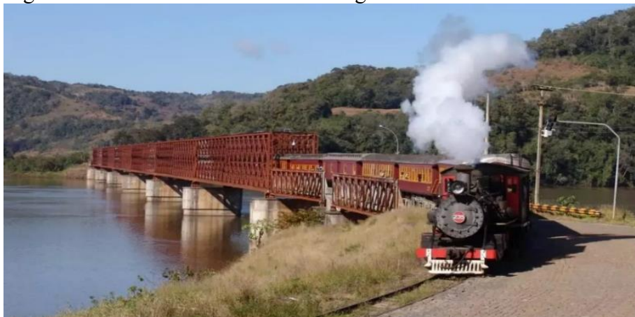
Figura 5- Ponte Férrea sobre o Rio Uruguai
