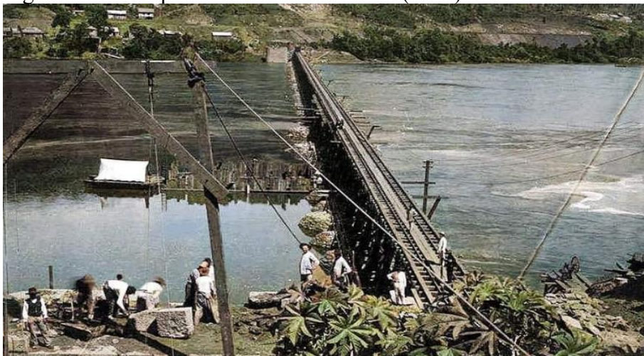
Figura 3 – Ponte provisória sobre o Pelotas (1911)
