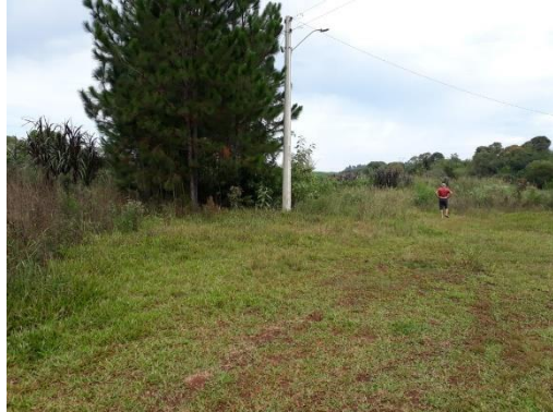
Figura 9: Poste de iluminação pública.
