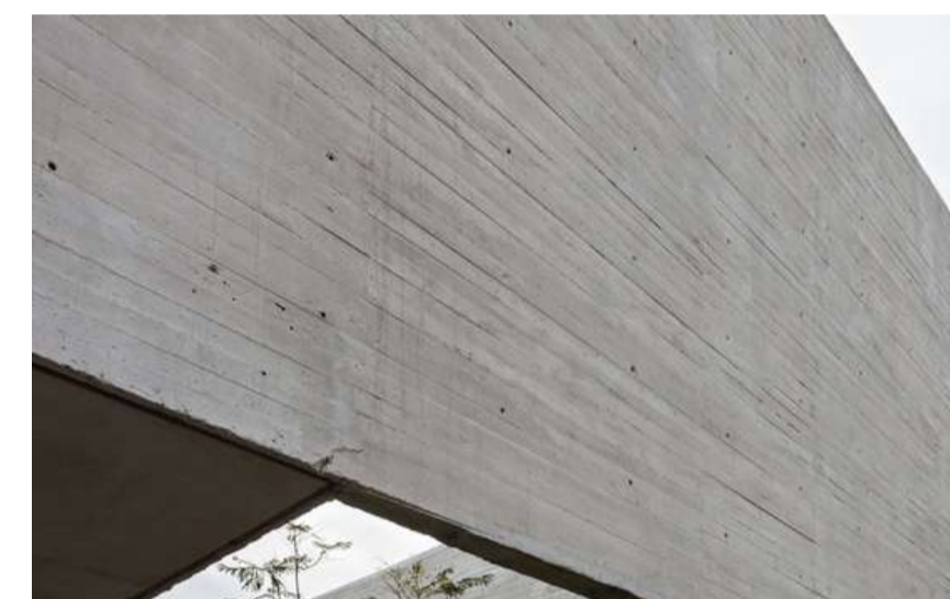
ACABAMENTO EM CONCRETO APARENTE Fonte : ArchDaily Brasil
