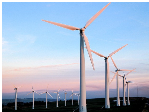
Figura 4 – Aerogerador de eixo horizontal
