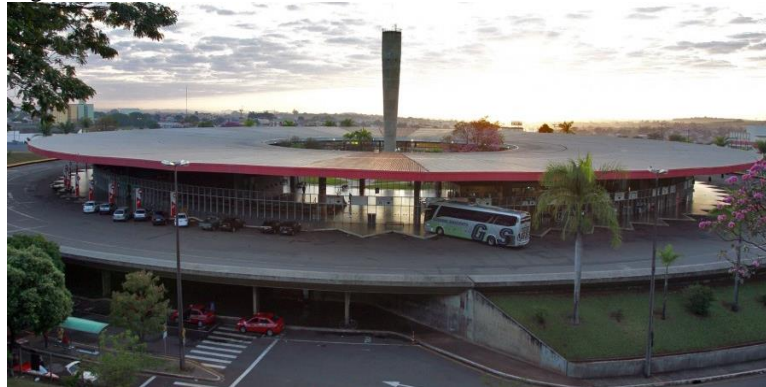
Figura 73 - Fachada do terminal rodoviário de Londrina
