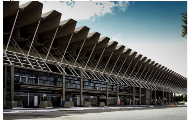
Figura 69 - Fachada principal do Terminal
