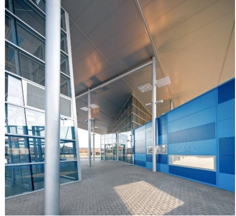
Figura 30 - Pilares e estruturas
