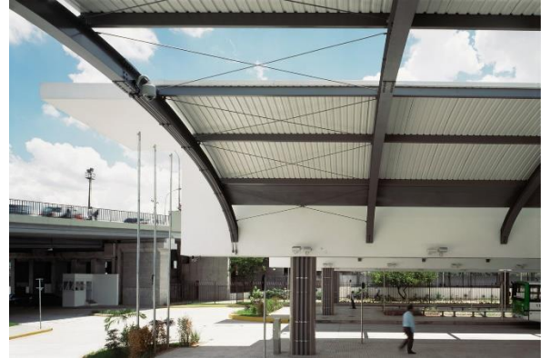
Figura 22 - Estrutura e aberturas na cobertura
