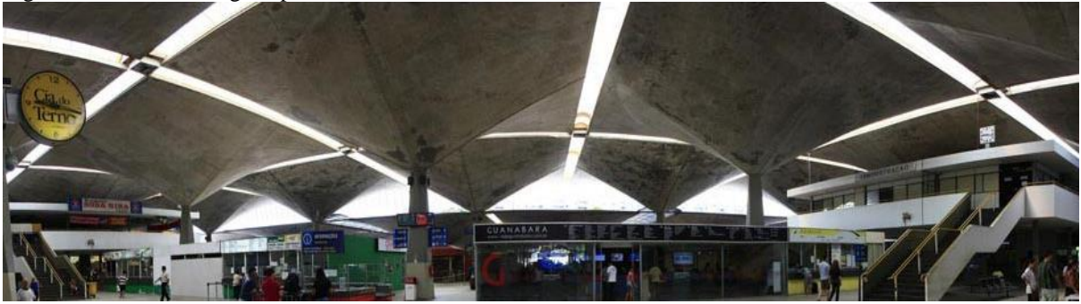
Figura 13 - Cobertura ligada por domos
