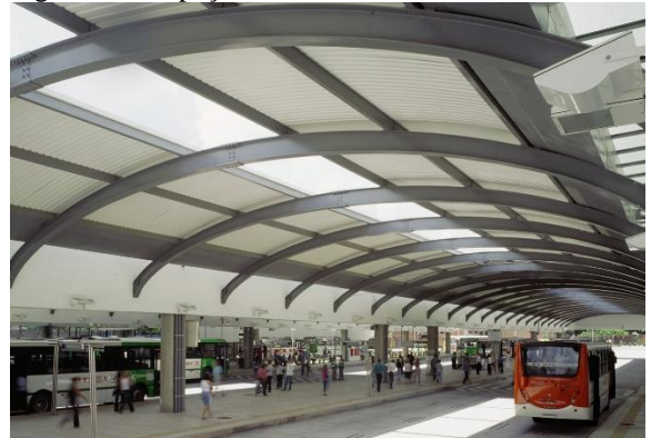
Figura 17 - Espaço interno do terminal
