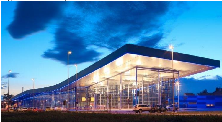
Figura 27 - Fachada, com evidência do telhado ondulado
