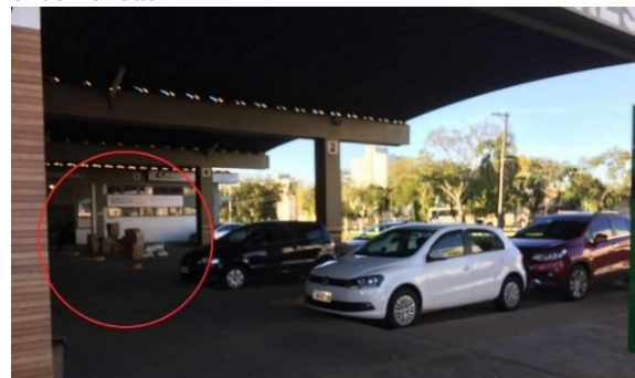
Figura 44 - Vista lateral do recebimento de encomendas
