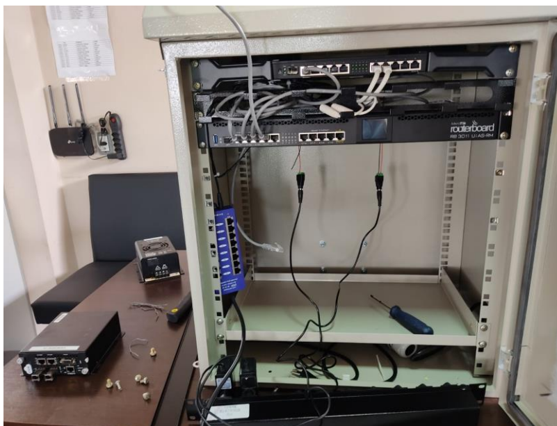
Figura 22 - Montagem do rack
