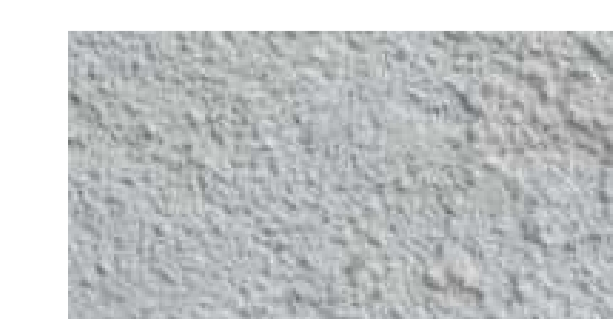
Muro revestido em estuque branco
