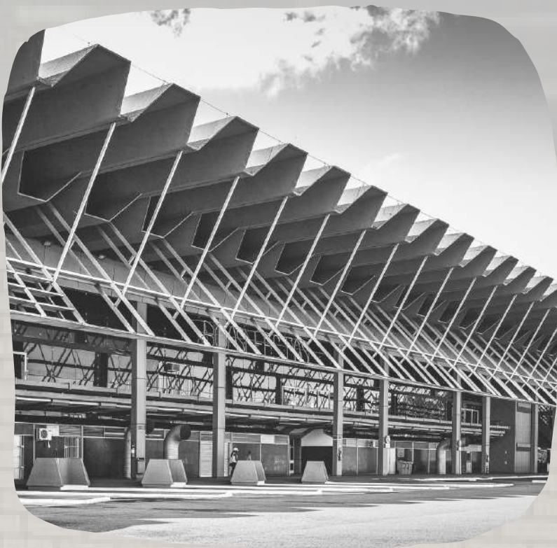
Terminal Rodoviário Rita Maria
