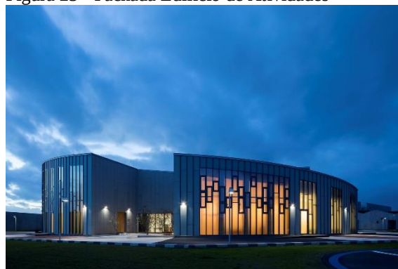
Figura 23 - Fachada Edifício de Atividades
