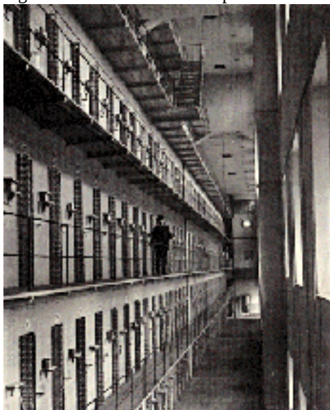
Figura 4 - Galeria de celas da prisão de Auburn
