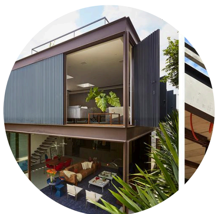
Estrutura de aço
