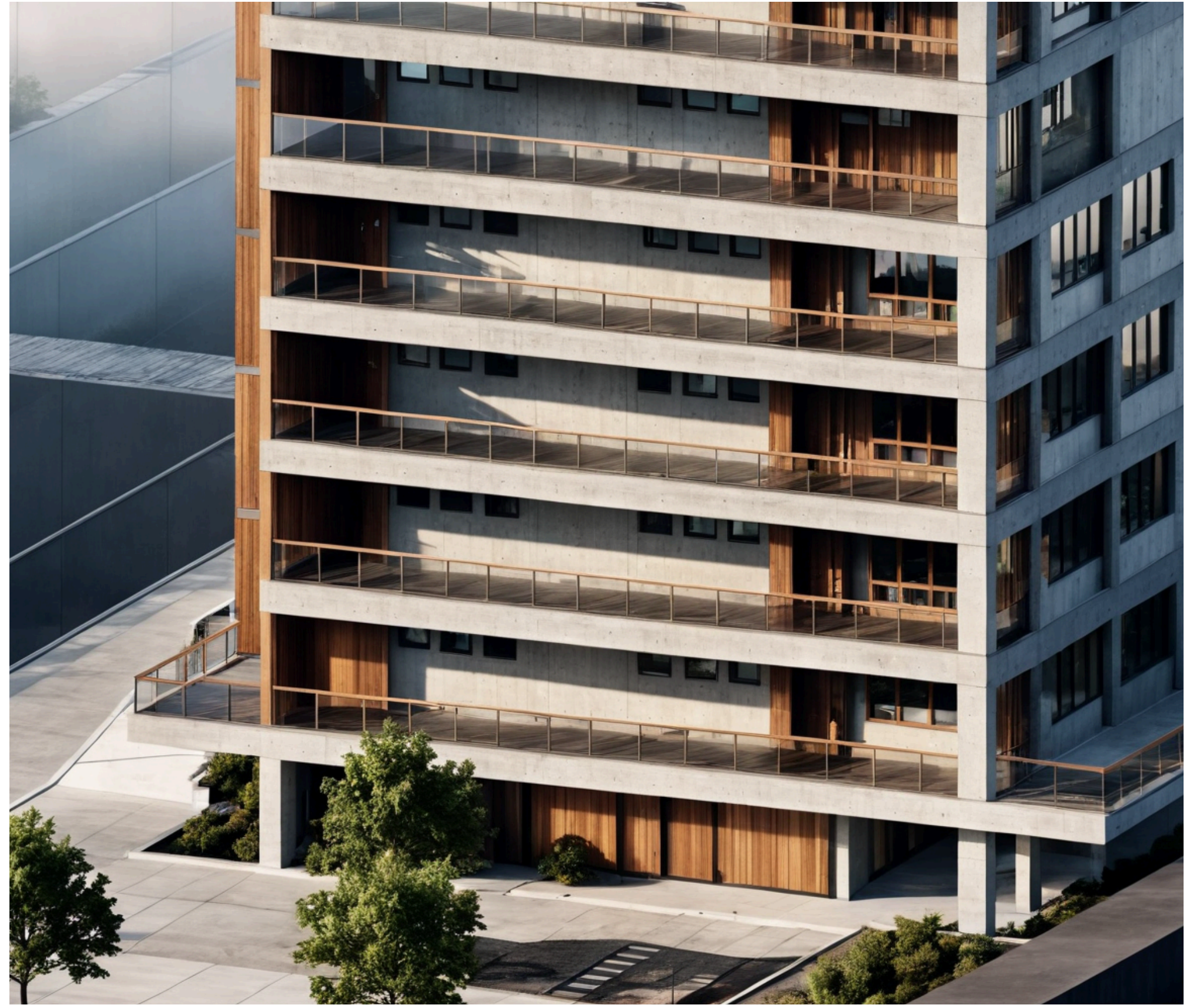
Fachada Sul - acesso estacionamento e varandas
