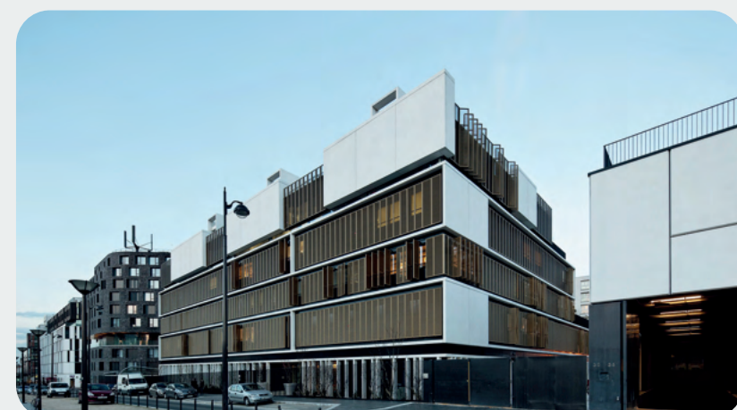
Estrutura em concreto
