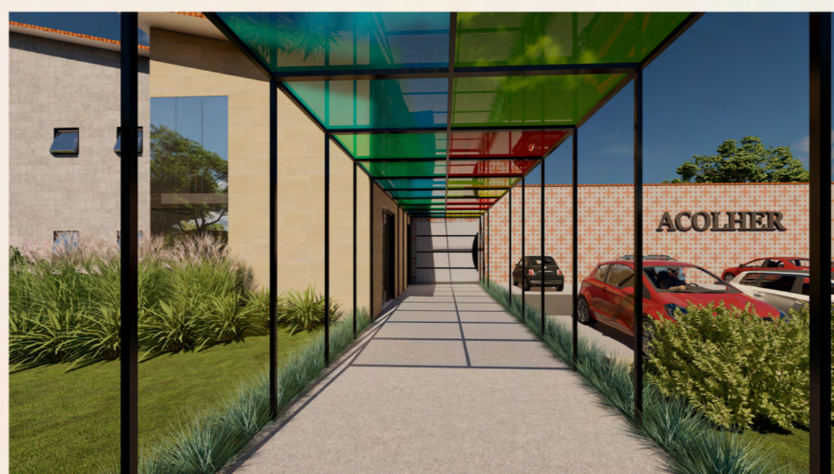
Cobertura em vidro colorido executada na entrada do complexo.
