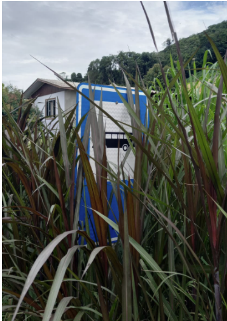
Figura 43 – Baixa visibilidade da placa devido a plantação
