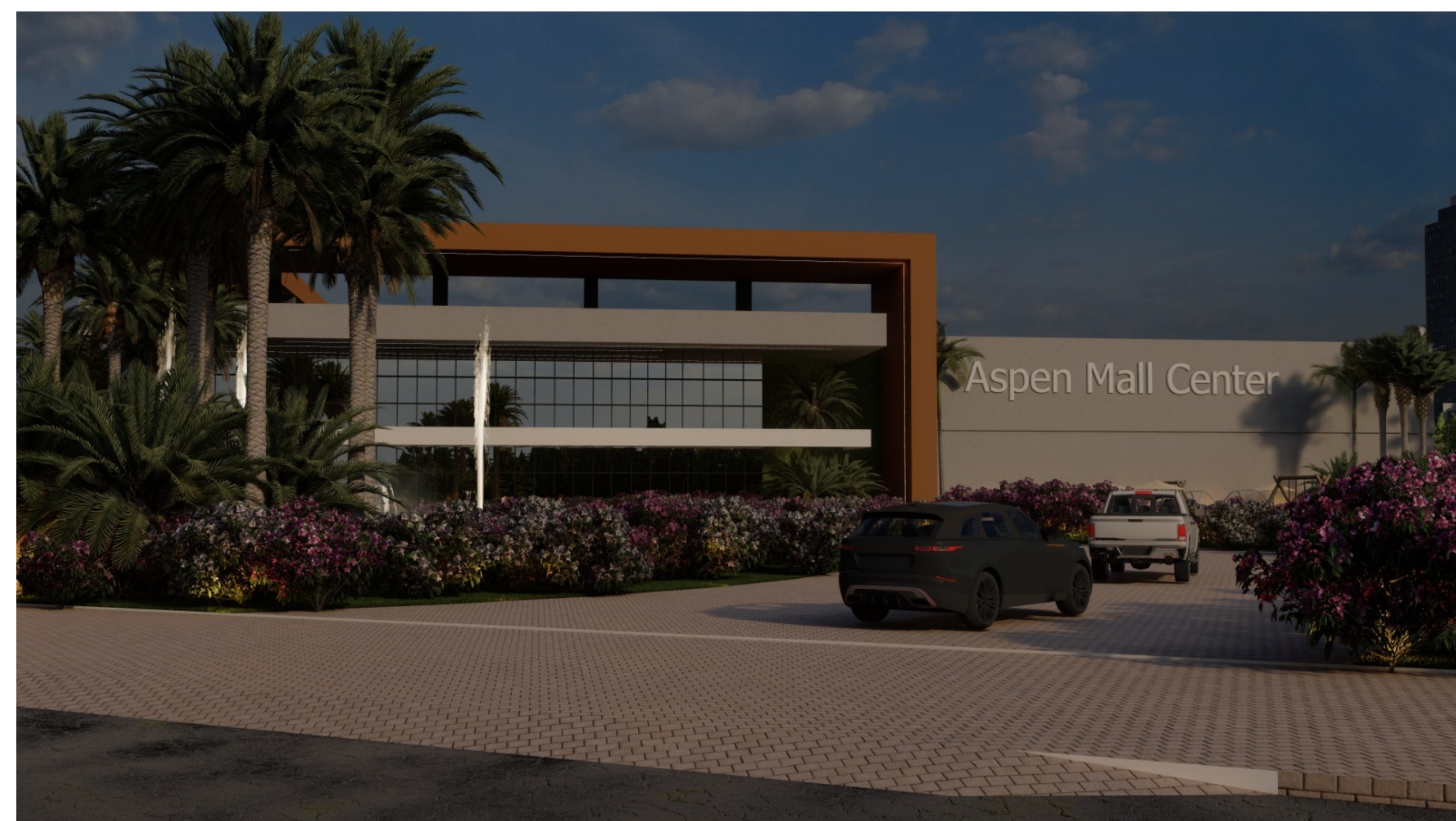
Acesso de veículos, destinado a veículo de aplicativos, táxi e pedestres.
