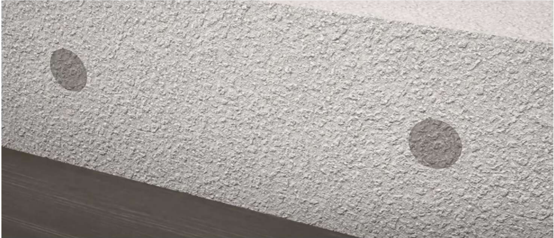
TAMPAMENTO DOS NICHOS DE PROTENSÃO
