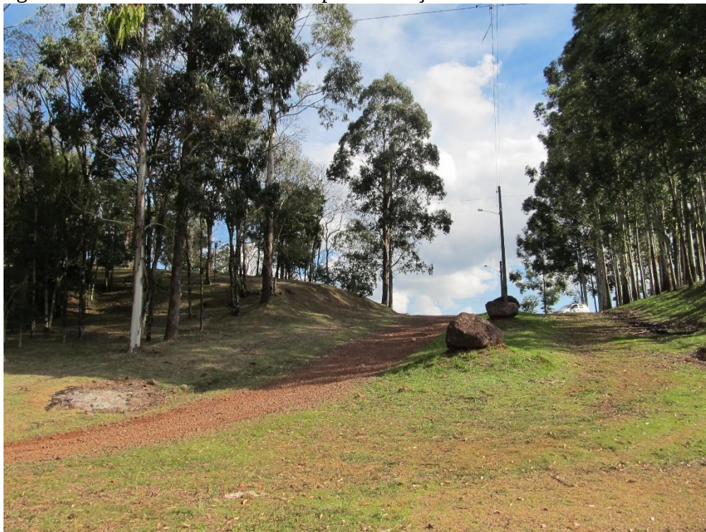
Figura 13 - Acessos ao terreno sem pavimentação
