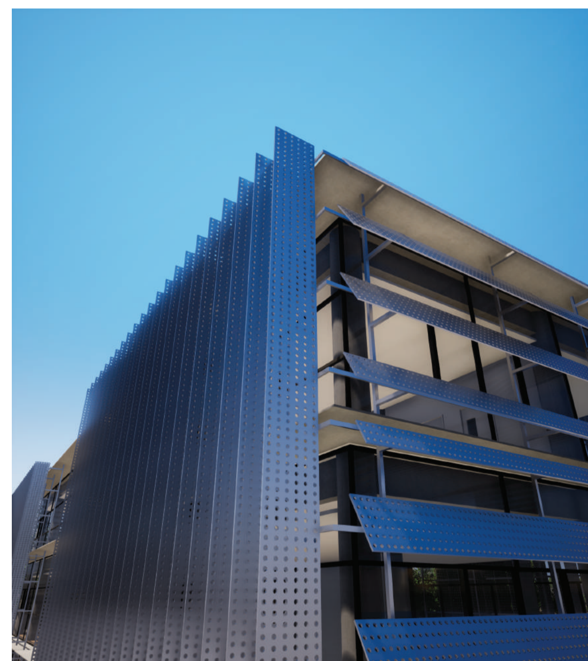
Brises verticais e horizontais do bloco 2.
