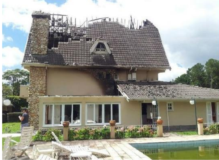
Figura 4 – Casa danificada por um raio.
