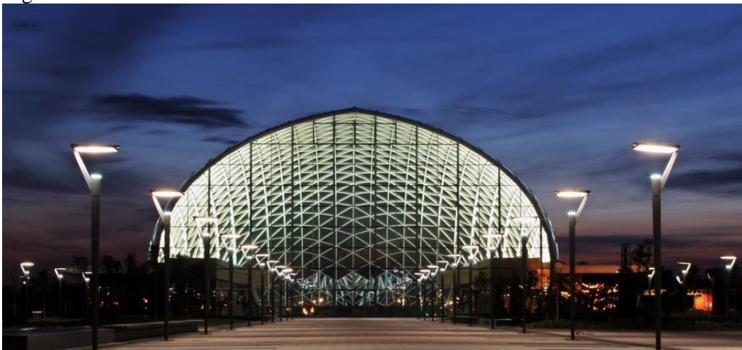
Figura 13 - Vista externa Centro de Eventos Feira de Valencia
