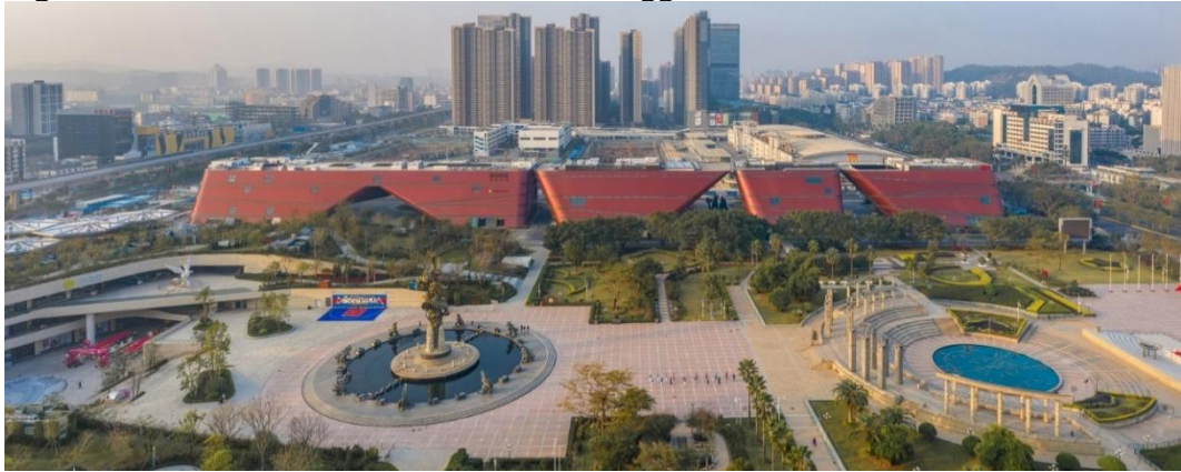
Figura 15 - Vista externa Centro Cultural Loggand
