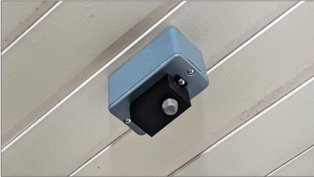
Figura 45 – Posicionamento do condutele para o sensor de gás e fumaça.
